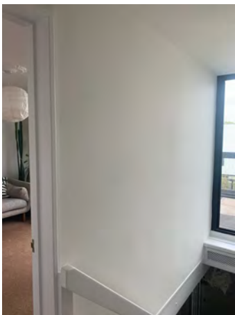
3. Stud wall view 1
