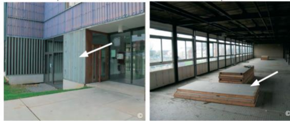
Figure 2.14: Rénovation de l'Athénée Riva Bella (Braine l'Alleud): parement extérieur et cloisons intérieures récupérés
