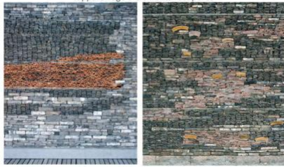
Figure 2.18: Musée d'histoire de Ningbo (Wang Shu): appareillage d'éléments récupérés
