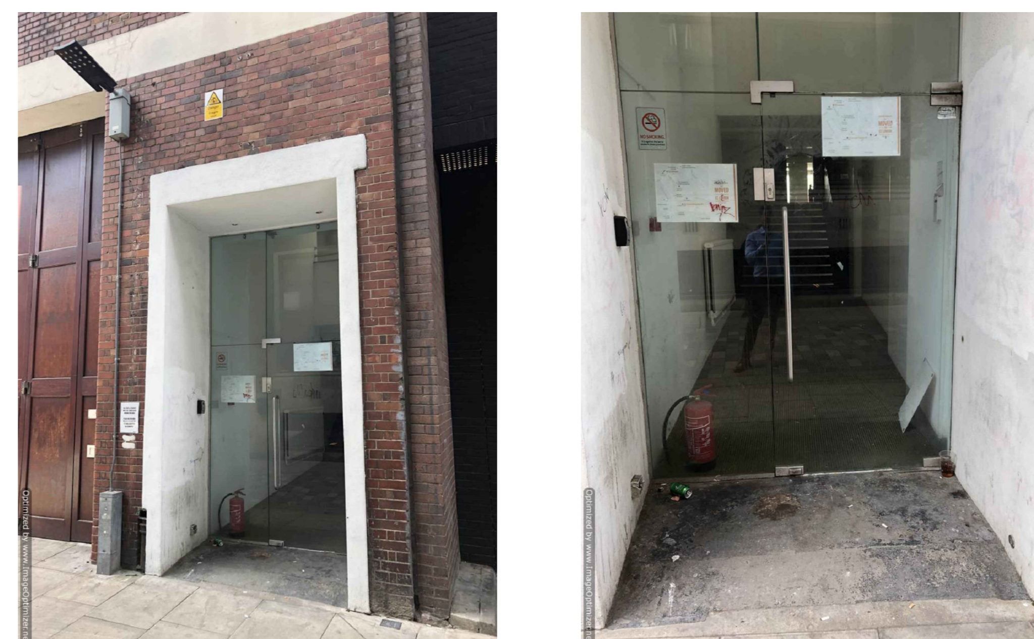
EXISTING DOOR PHOTOGRAPHS
