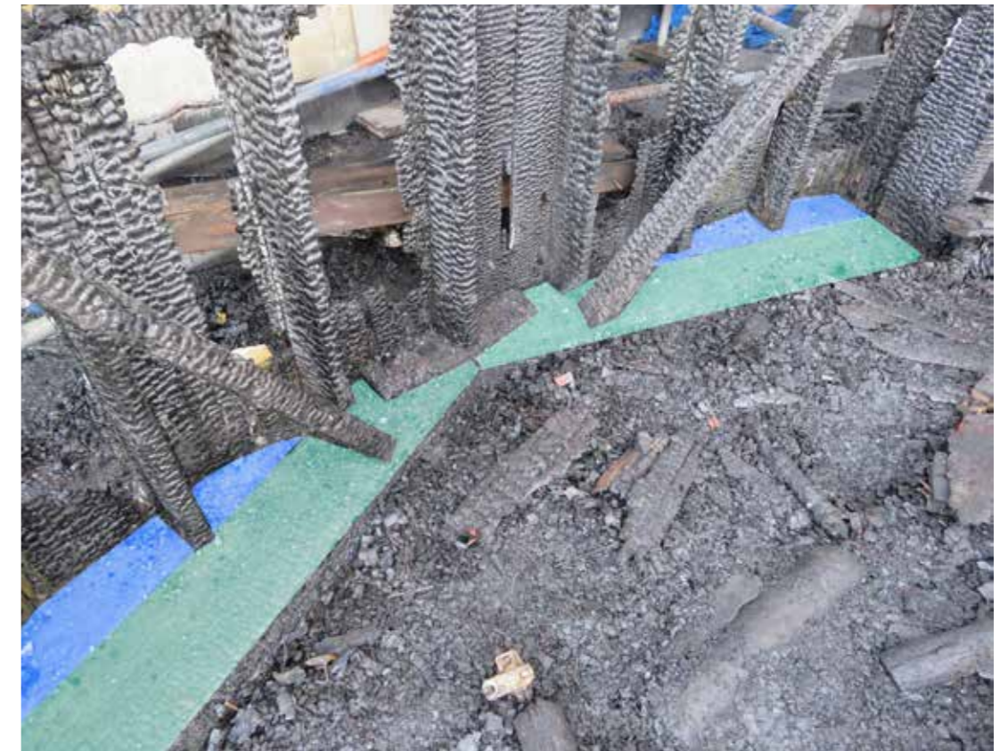
Figure 76: Lower stud wall plates (D) in situ (2020) © SLHA
