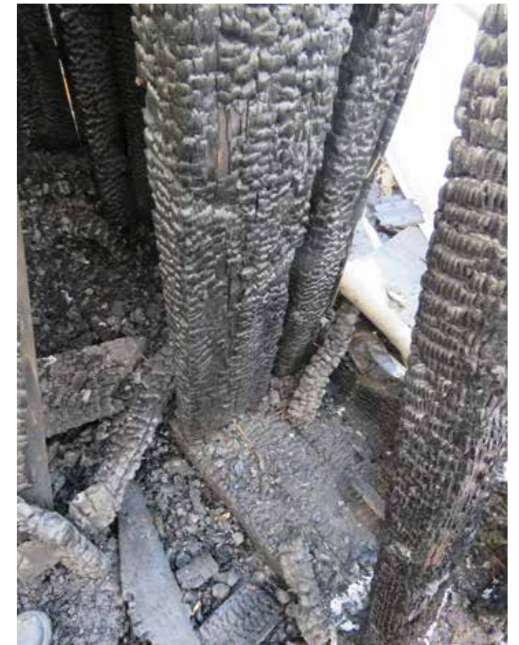
Figure 88: Lower stud wall plate (D) in situ (2020) © SLHA
