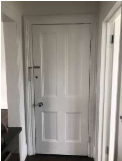
Entrance door Door 1
