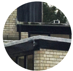
Black timber fascias
