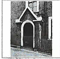
115334: 2 Tomiario Cottages: doorway
