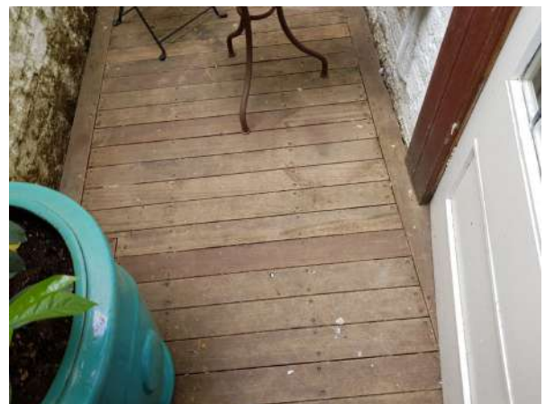
MH01 BENEATH DECKING
