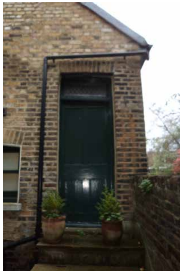
Existing door DLGF-26
