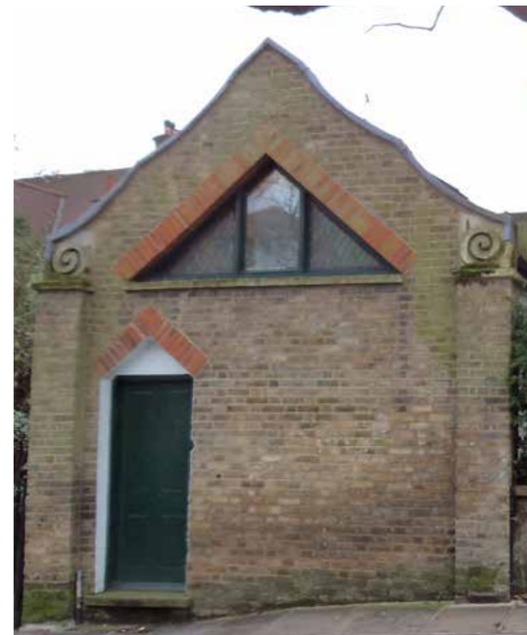
Existing door DLGF-27
