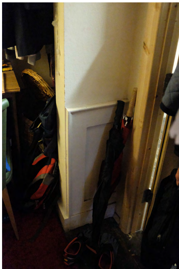
2E. Back Right Room 3141.JPG
