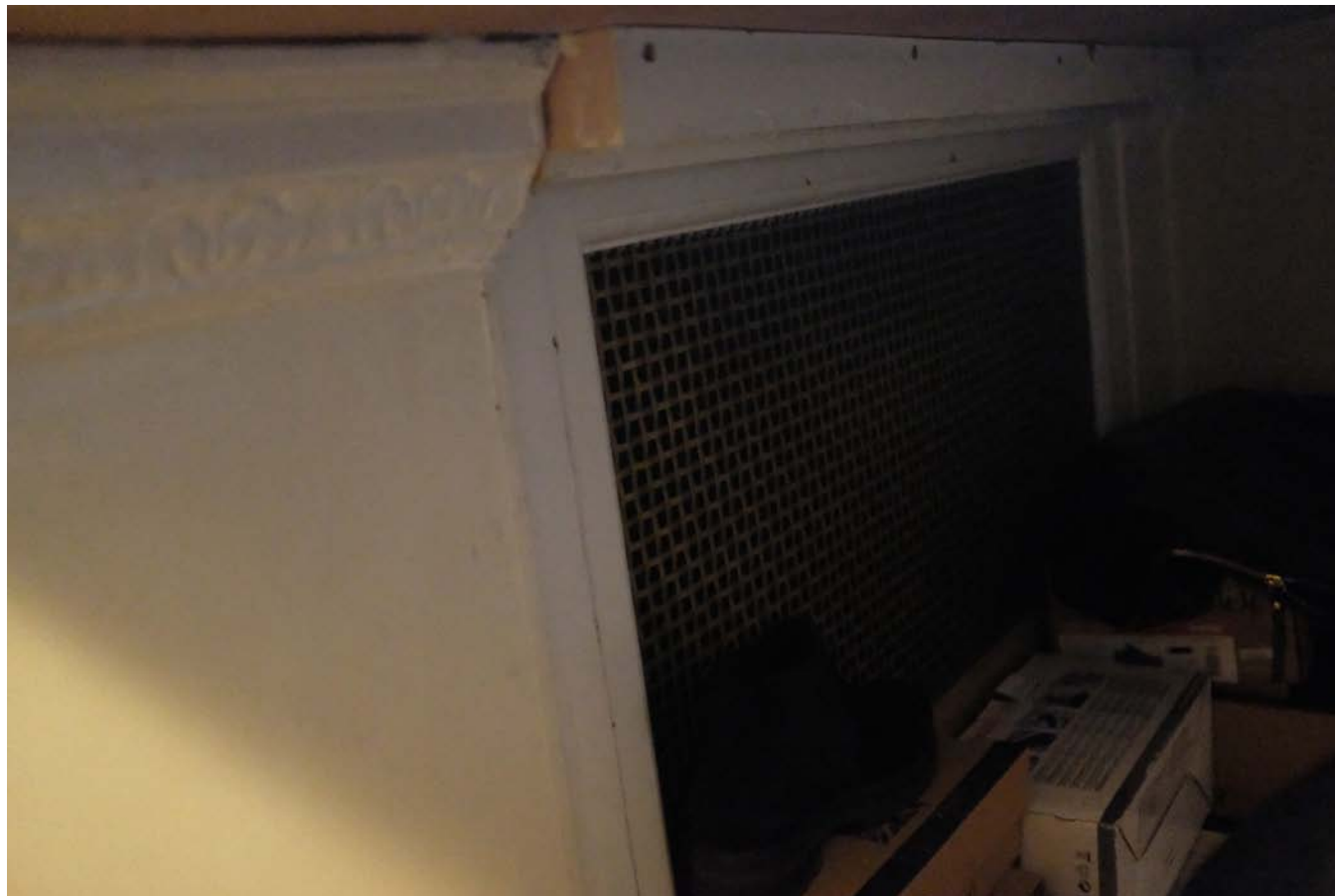
1C. Back Left Room 3039.JPG
