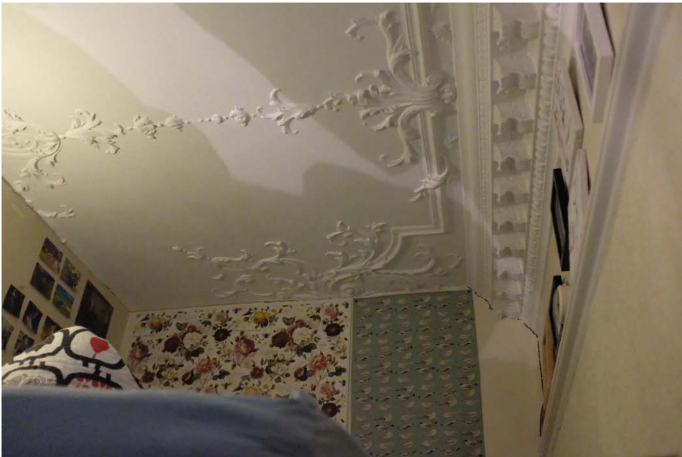
1C. Back Left Room 3034.JPG
