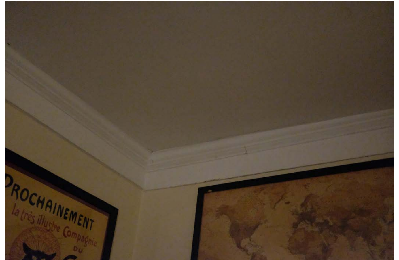
2E. Back Right Room 3140.JPG
