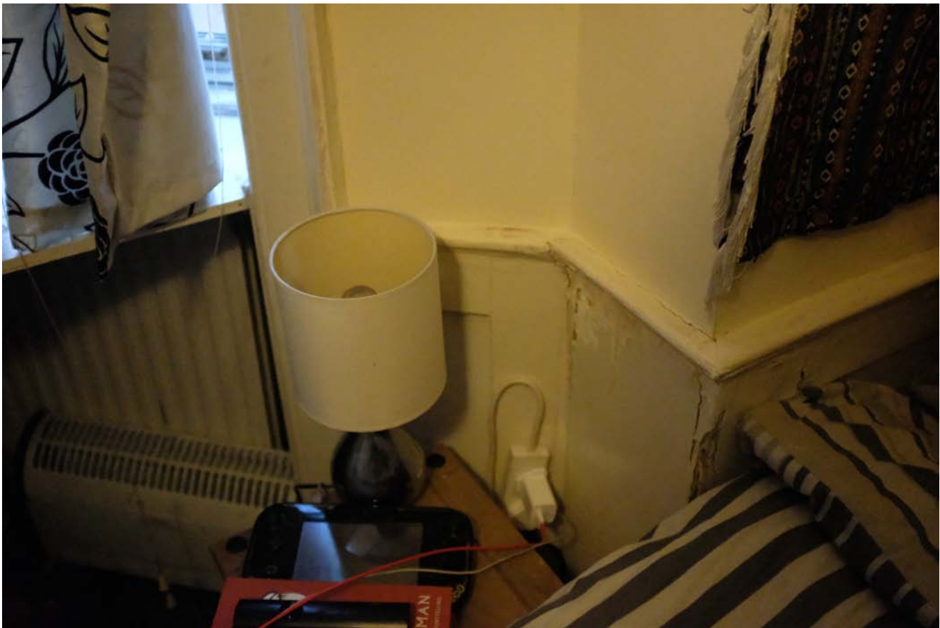
2E. Back Right Room 3133.JPG
