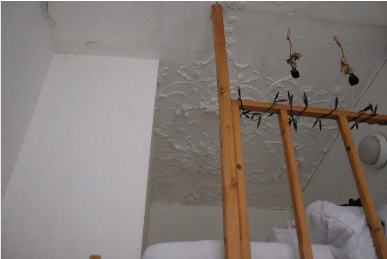
1E. Back Right Room 3046.JPG
