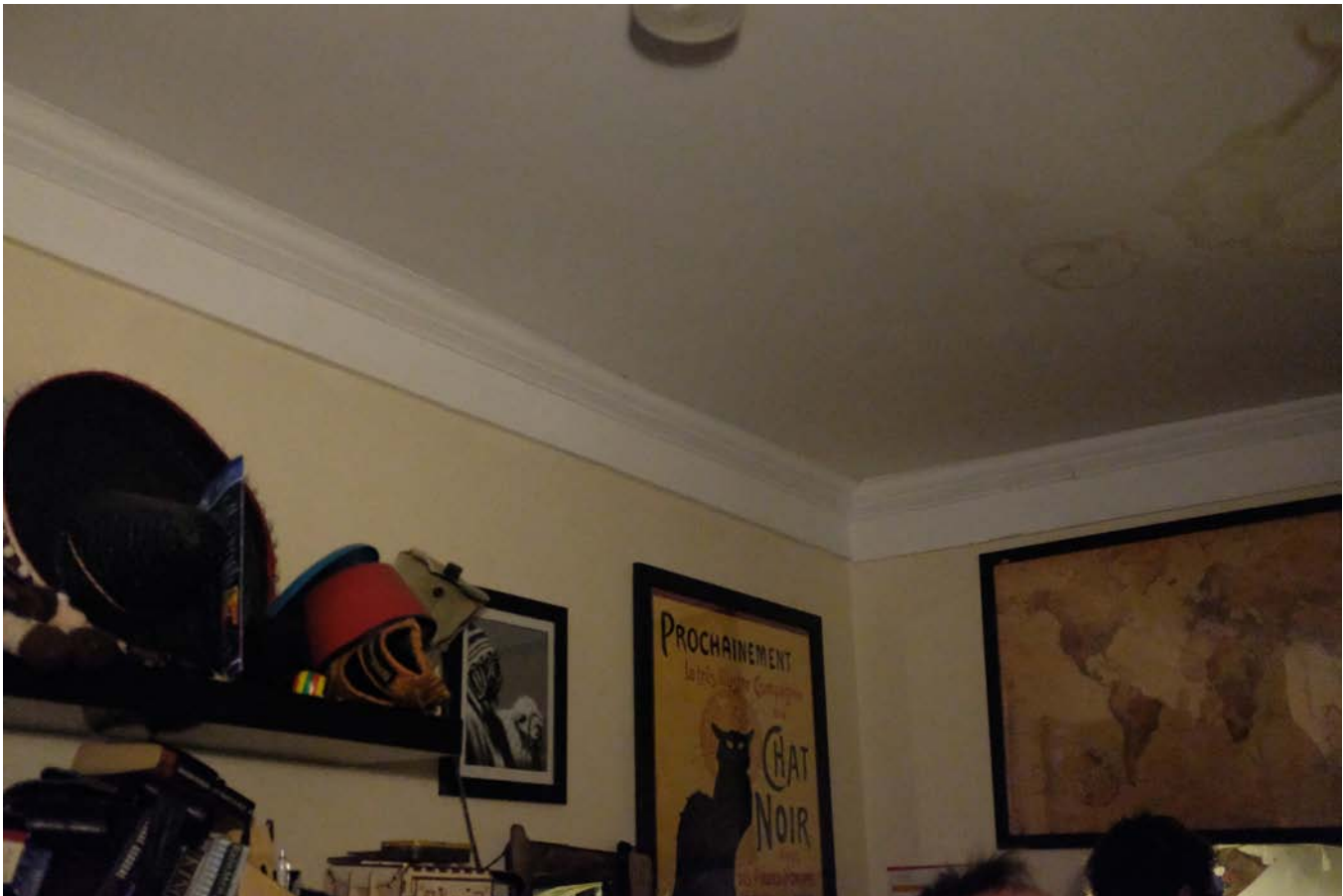
2E. Back Right Room 3136.JPG
