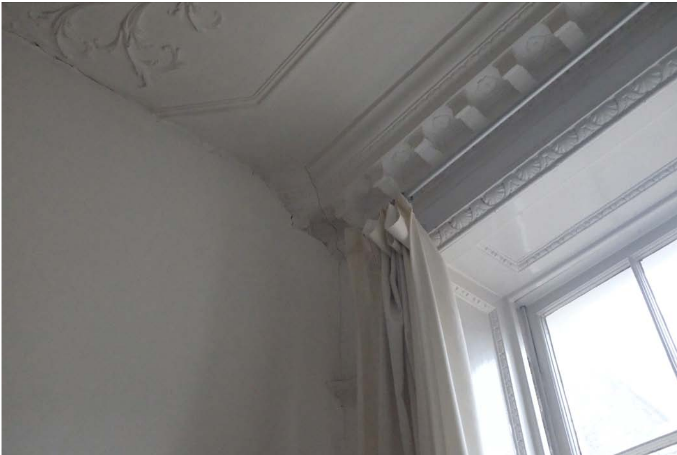
1E. Back Right Room 3045.JPG
