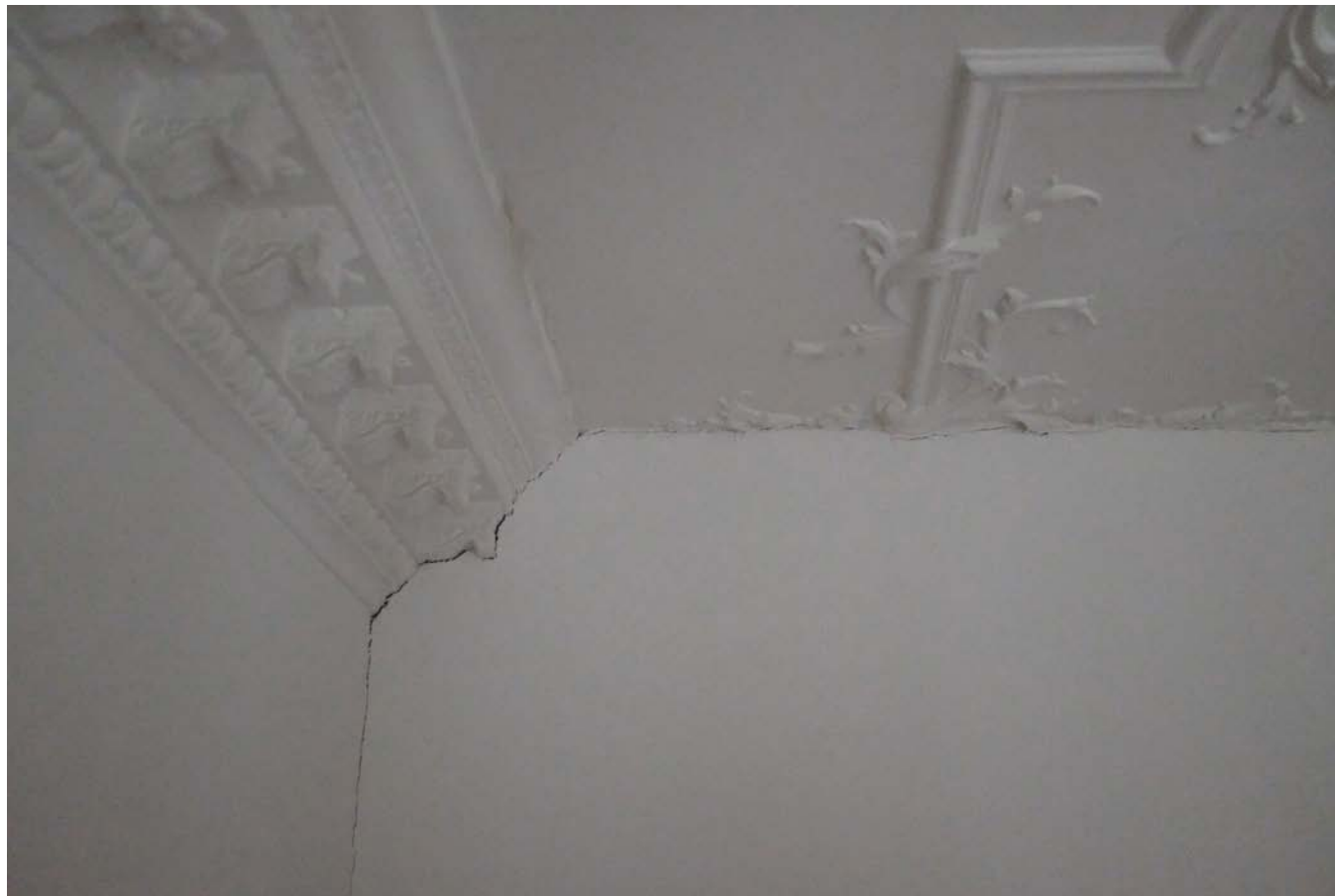
1E. Back Right Room 3052.JPG
