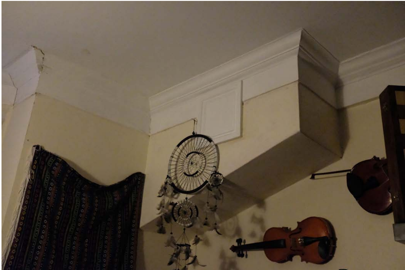
2E. Back Right Room 3132.JPG
