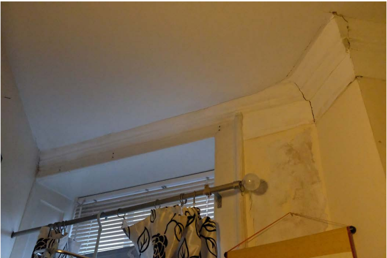
2E. Back Right Room 3134.JPG
