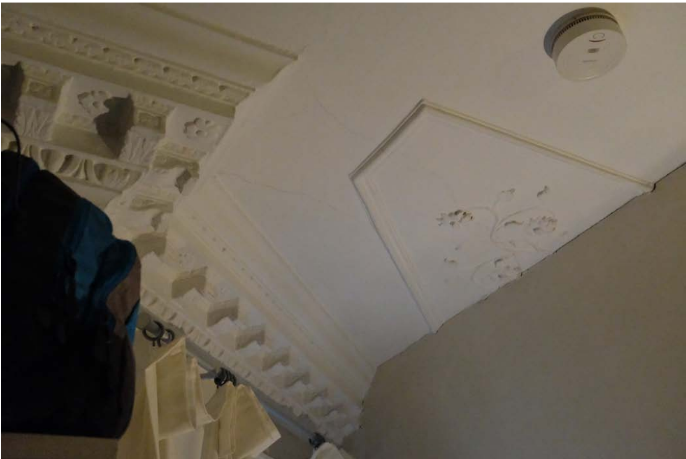
1C. Back Left Room 3038.JPG
