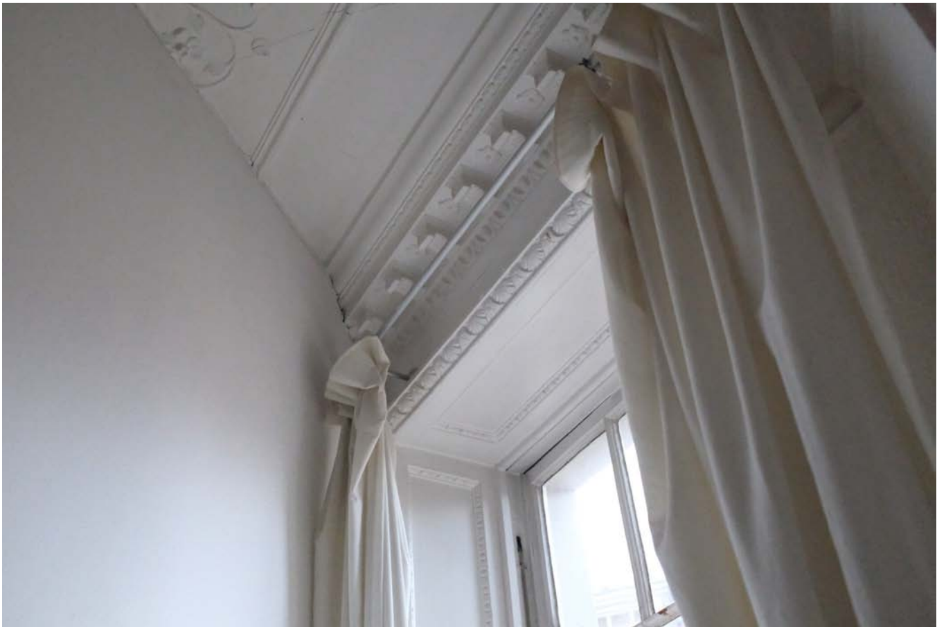
1E. Back Right Room 3049.JPG
