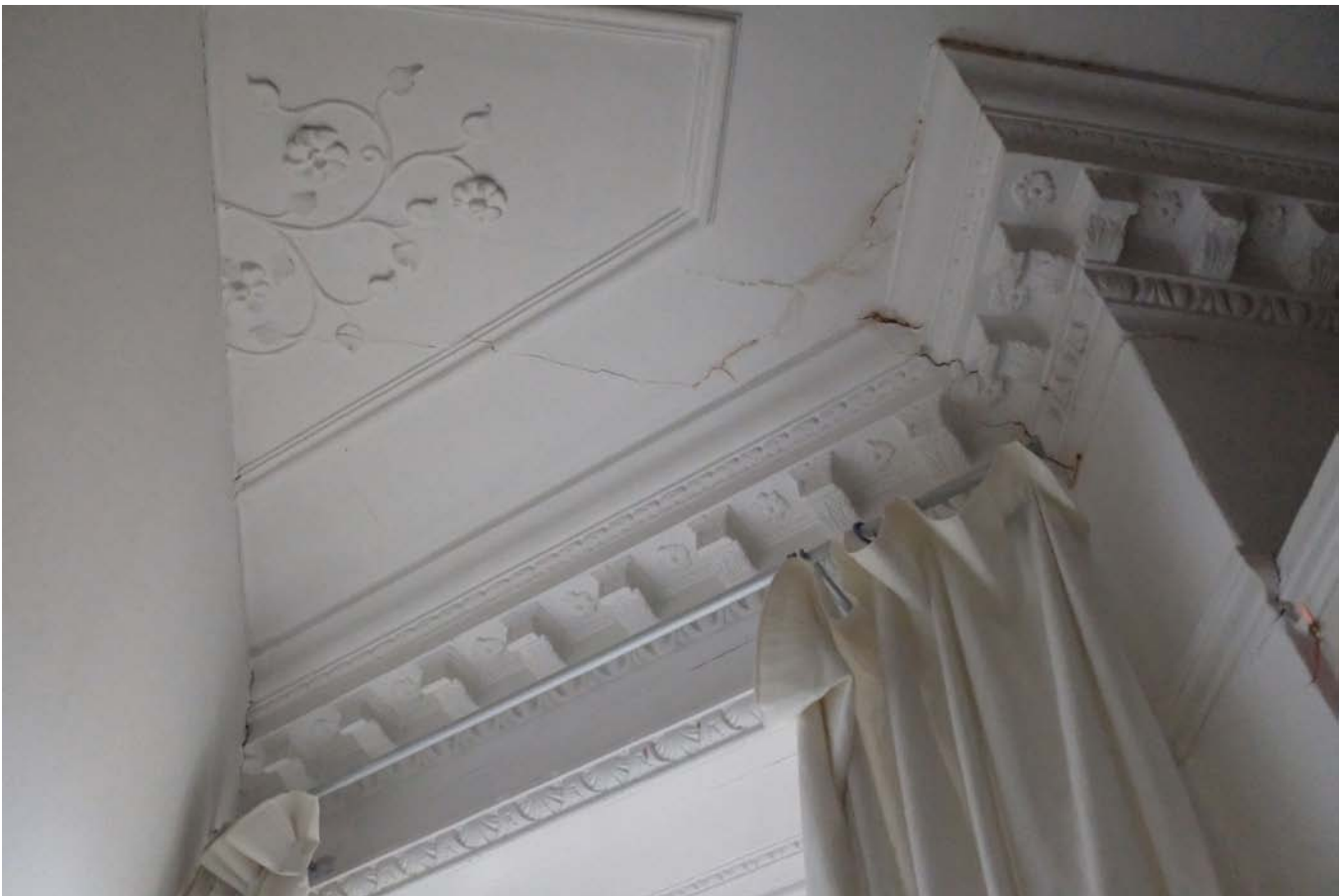
1E. Back Right Room 3048.JPG
