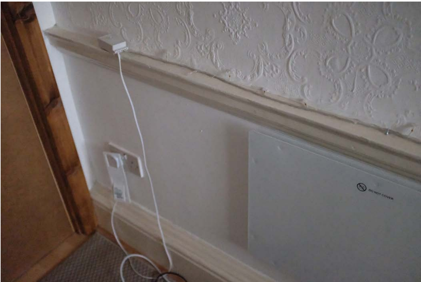
1A. Front Room 3007.JPG
