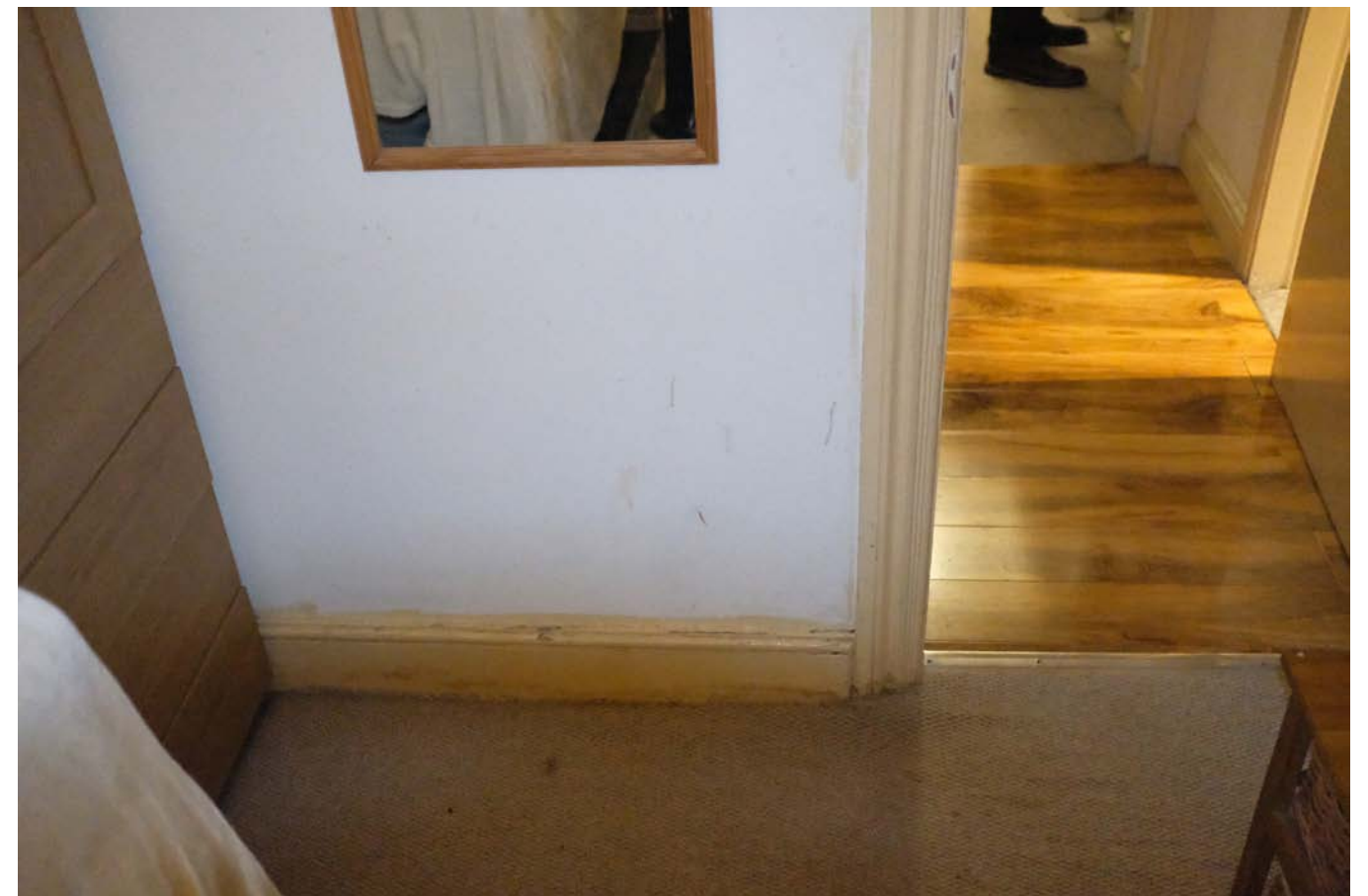
-1 E. Back Right Room 3203.JPG
