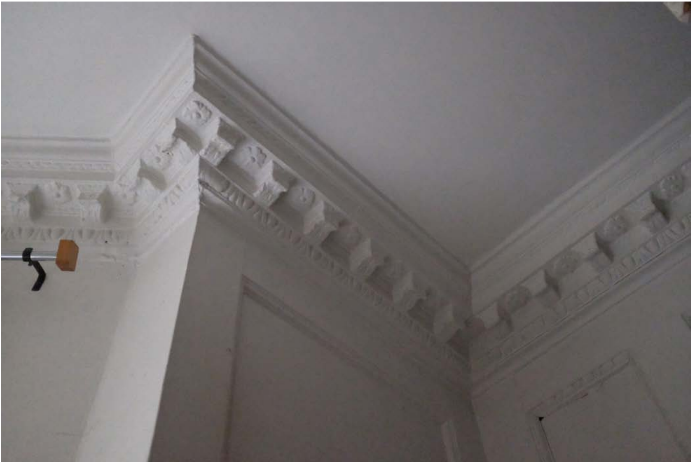
OE. Back Right Room 2967.JPG
