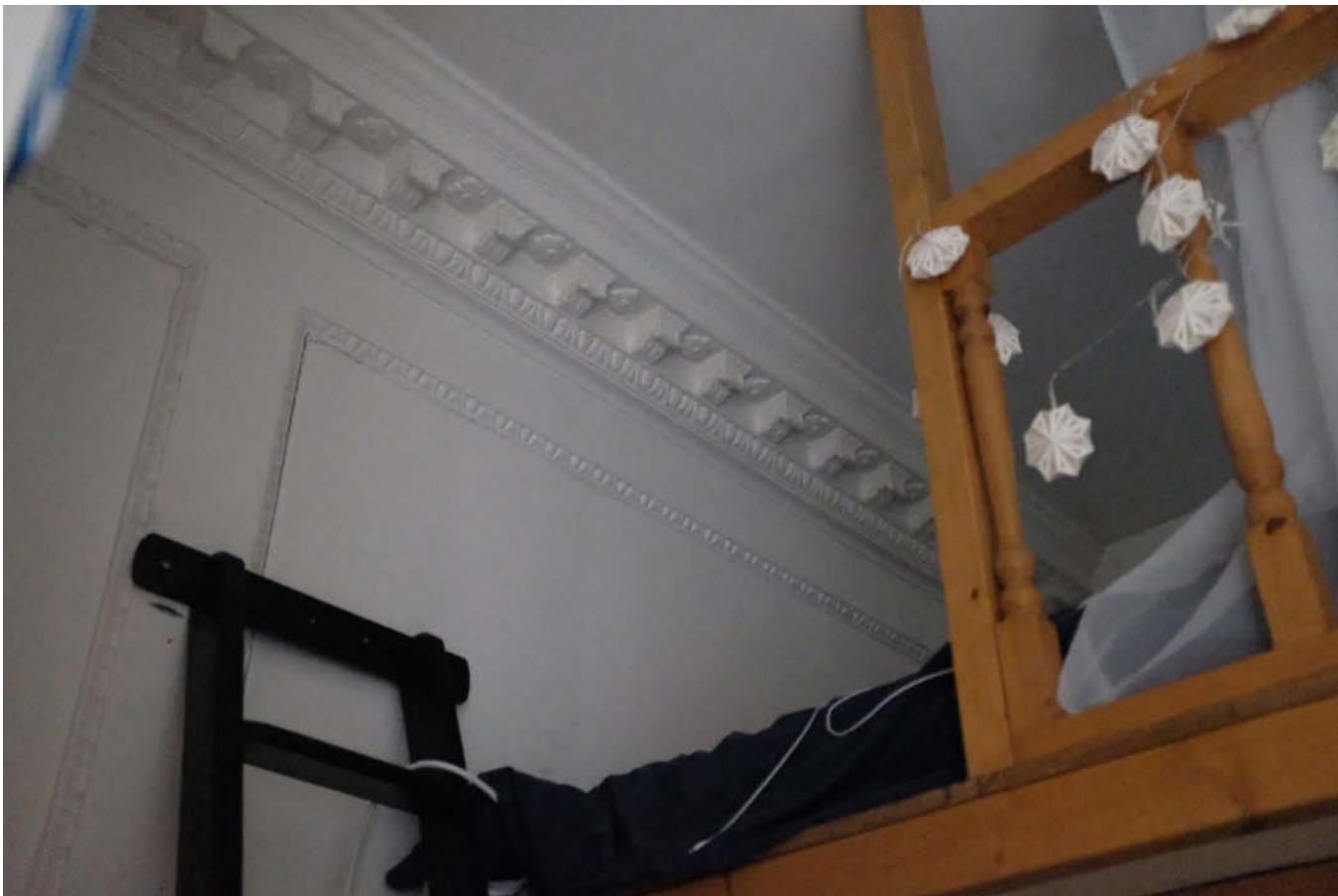
OE. Back Right Room 2970.JPG
