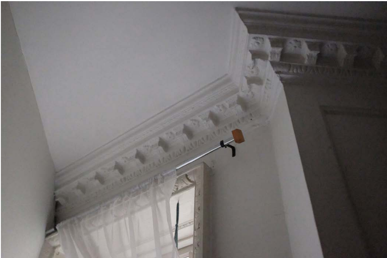
OE. Back Right Room 2966.JPG
