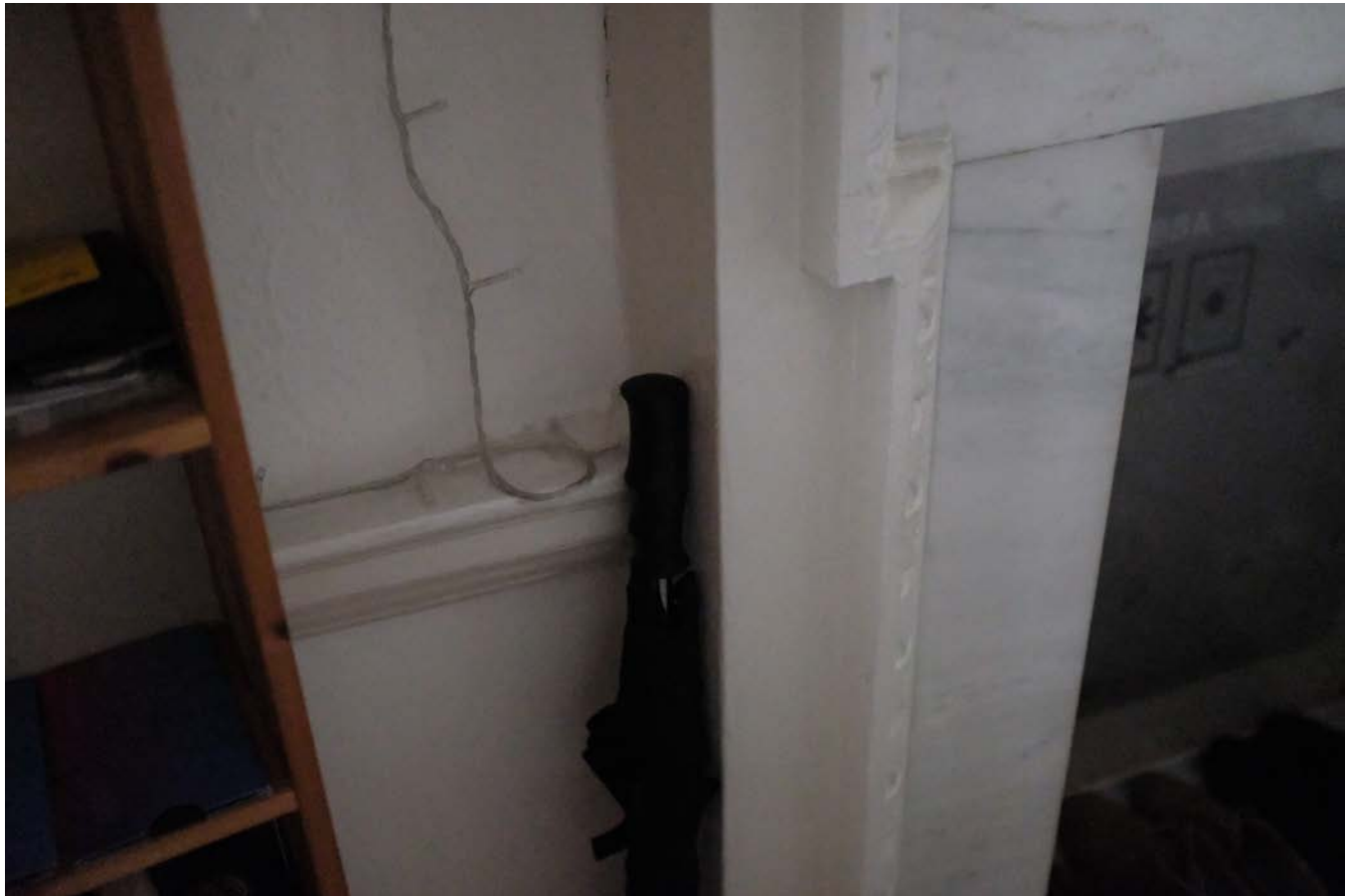
1A. Front Room 3005.JPG
