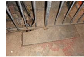
MH 12 NO ACCESS.JPG
