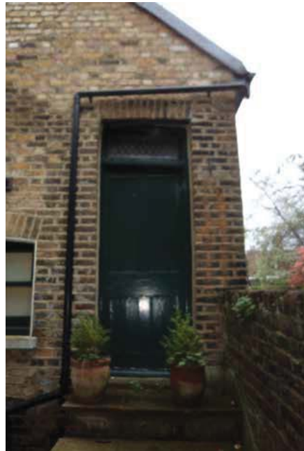
Existing door DLGF-26
