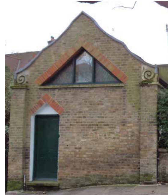
Existing door DLGF-27
