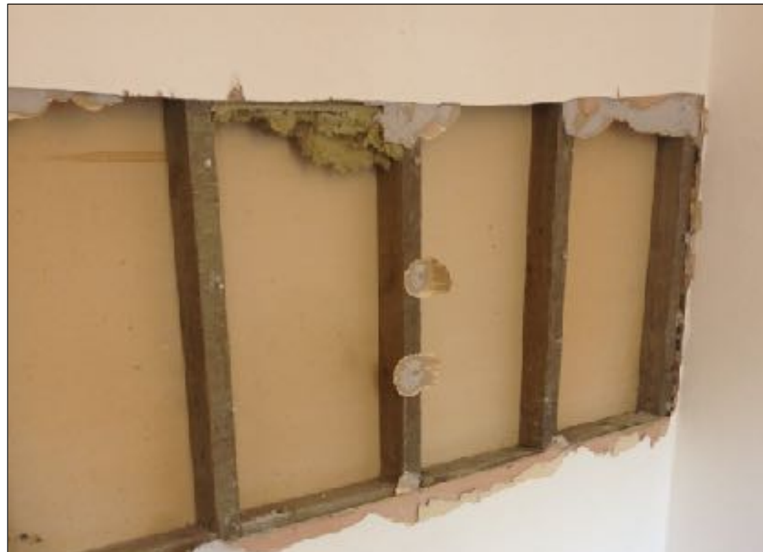
Above : Stud partition construction
