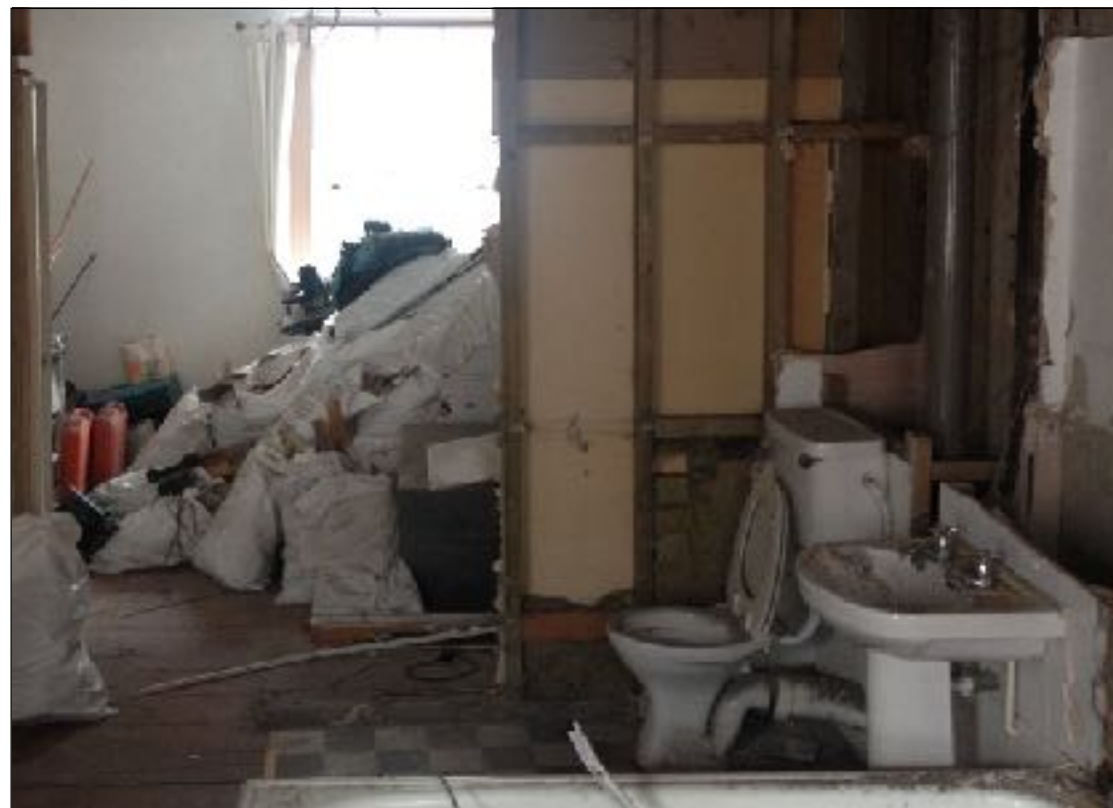
Above : Stud partition construction
