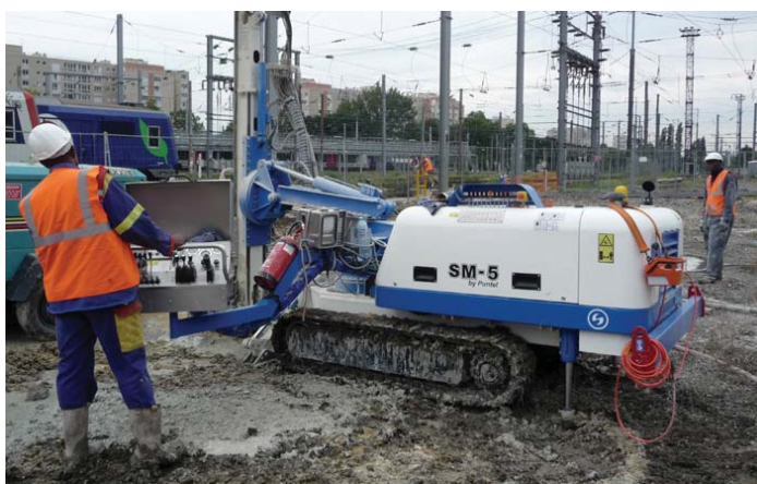
SM-5 Miniature piling rig
