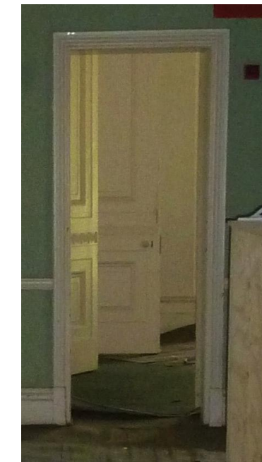
Existing Hallway Door
