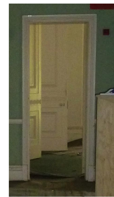
Existing Hallway Door
