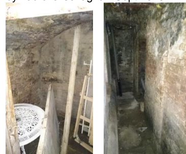
9a,b. Basement vaults
