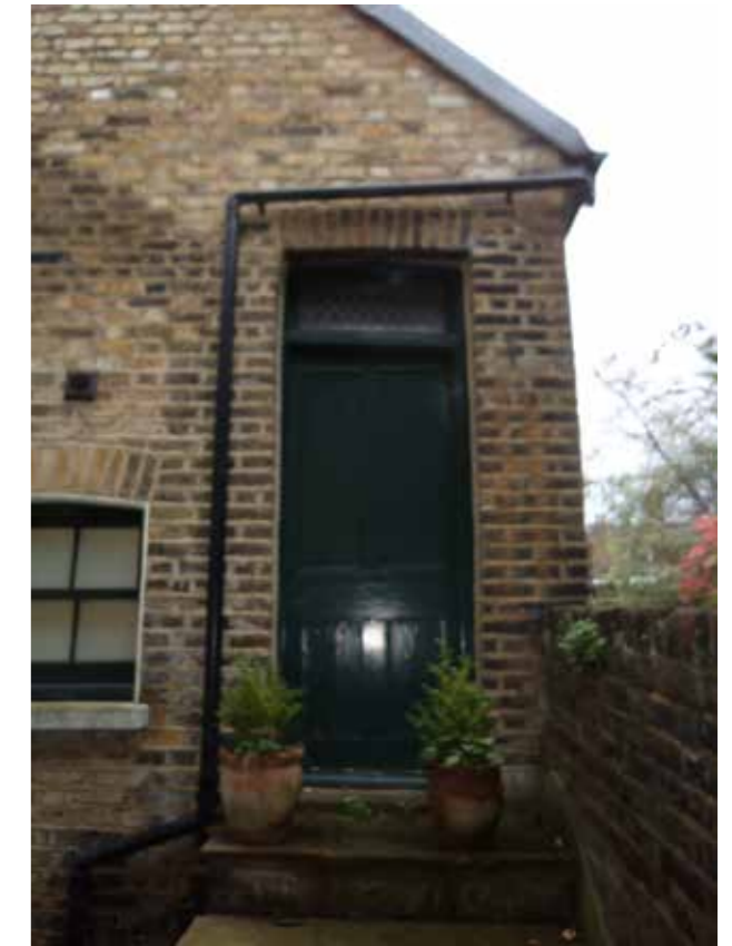
Existing door DLGF-27
