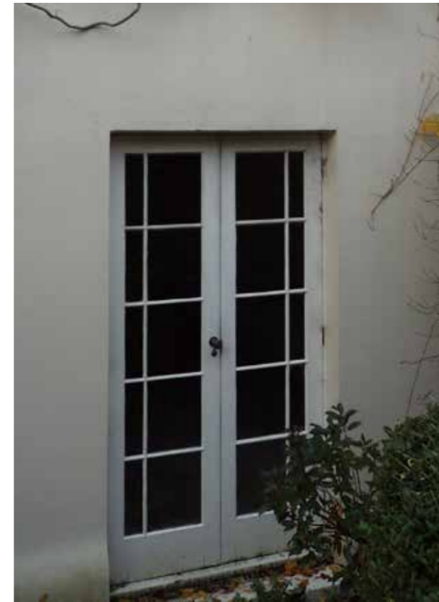
Existing door DLGF-09
