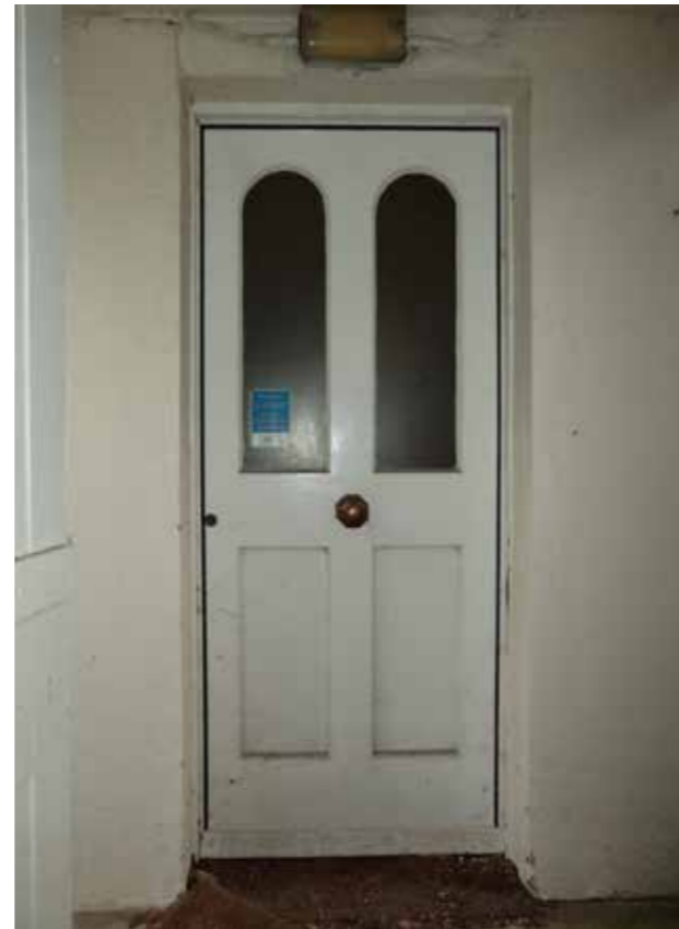
Existing door DLGF-07
