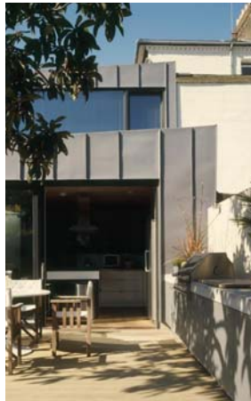
Fig 3x. Zinc clad extension.
