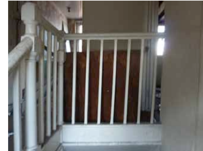
3 EXISTING STAIR 3F LANDING N.T.S.
