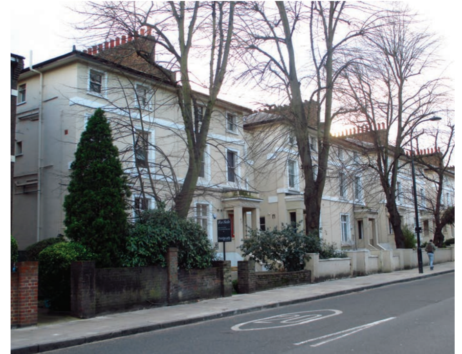
Fig. 7.21: Nos. 23-49 Adelaide Road.
