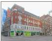
Medius House 63-69 New Oxford St London, WC1A 1DG
