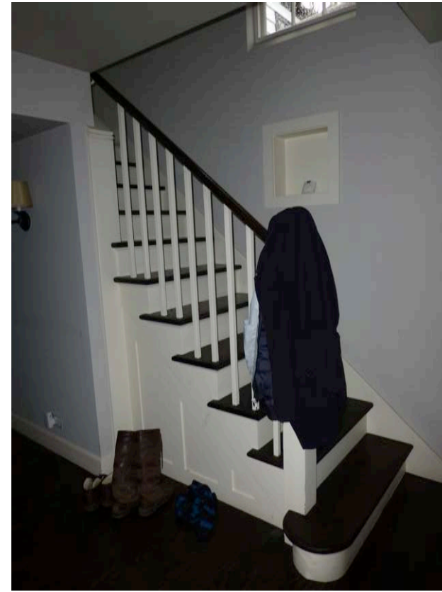
Non original staircase
