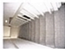
10 Stairs & Landing 01.JPG
