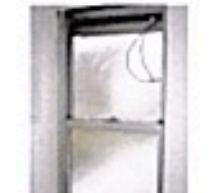
10 Stairs & Landing 04.JPG
