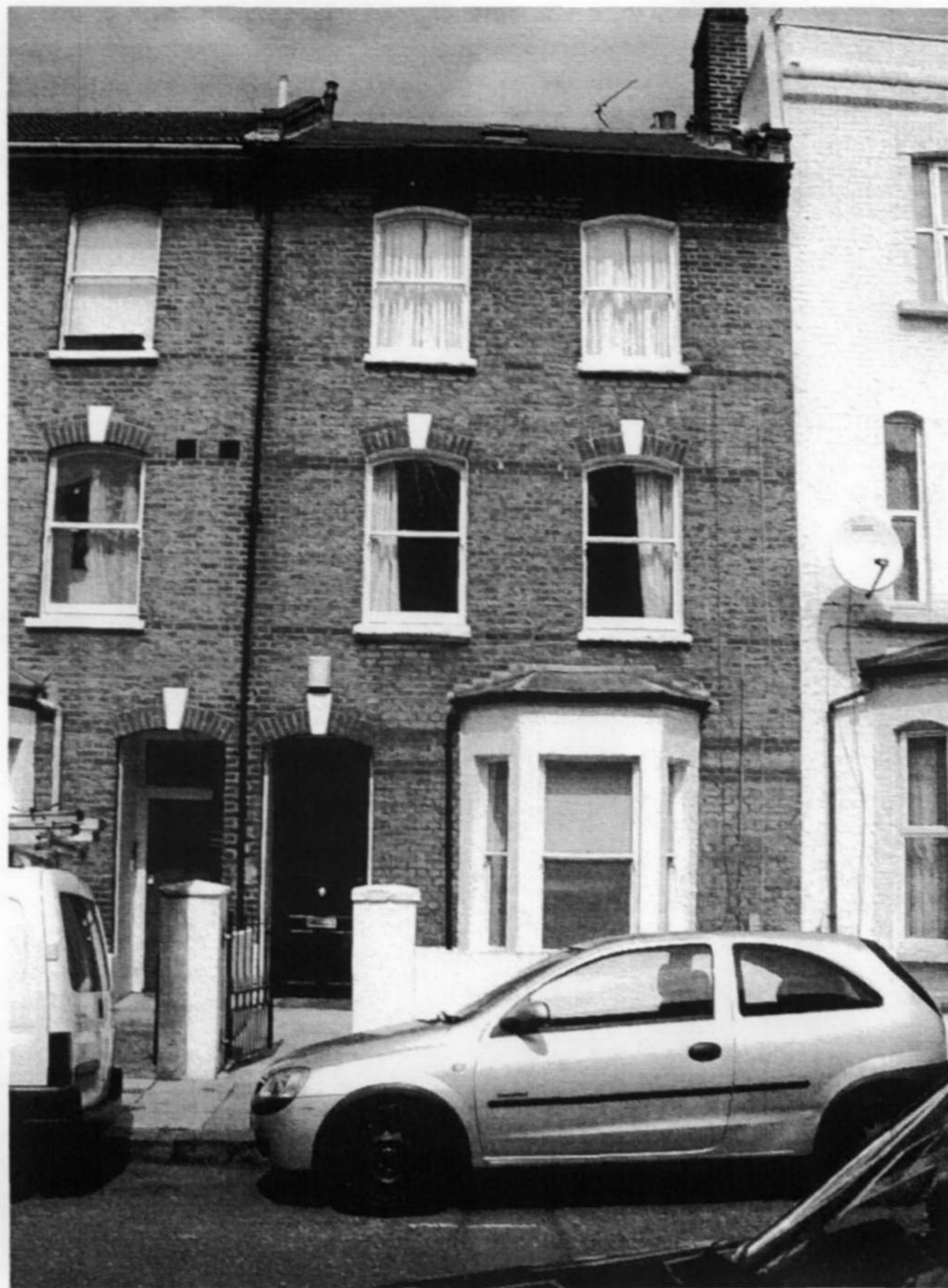
Nr 18 LOVERIDGE ROAD NW6
