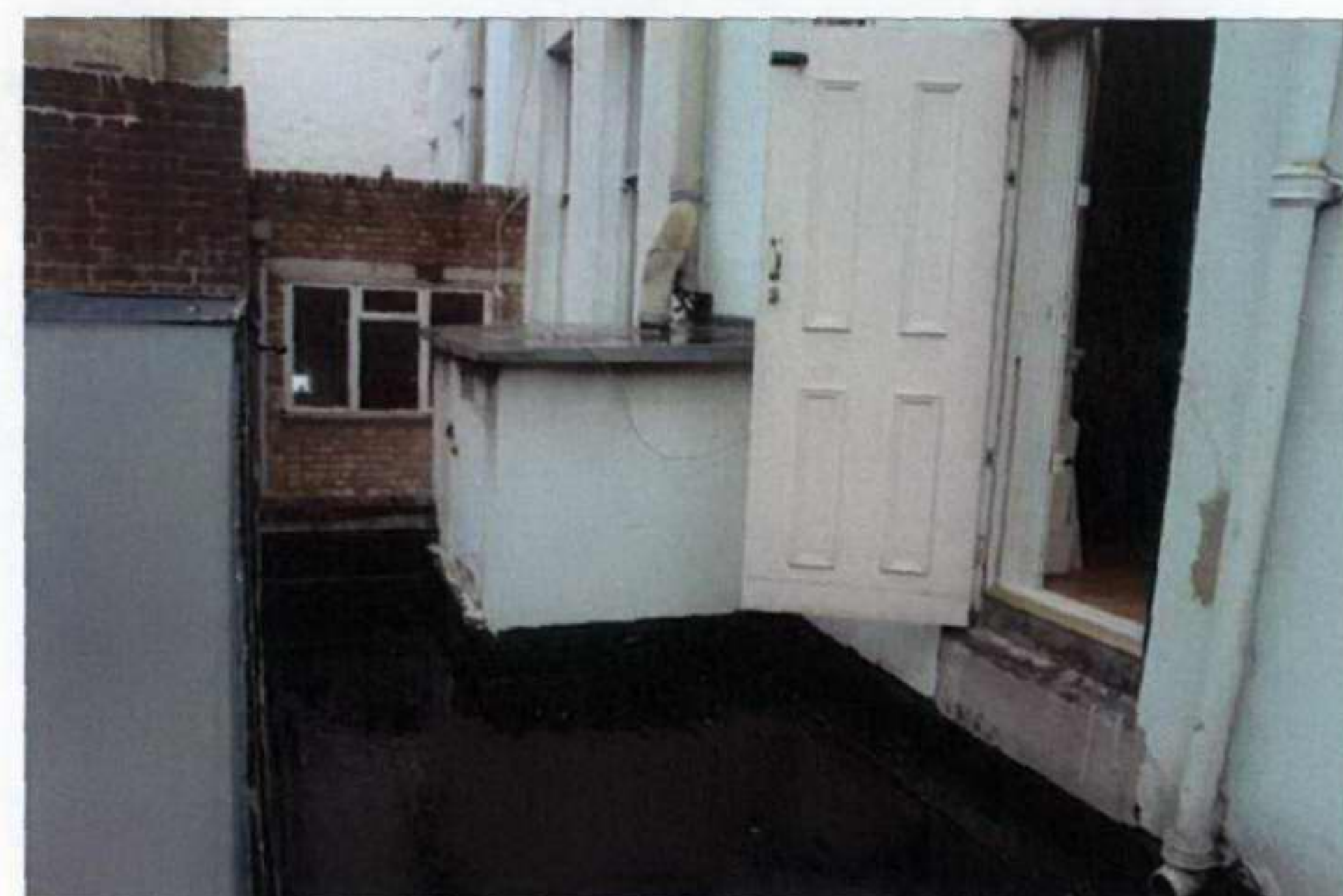
8. Door onto roof
