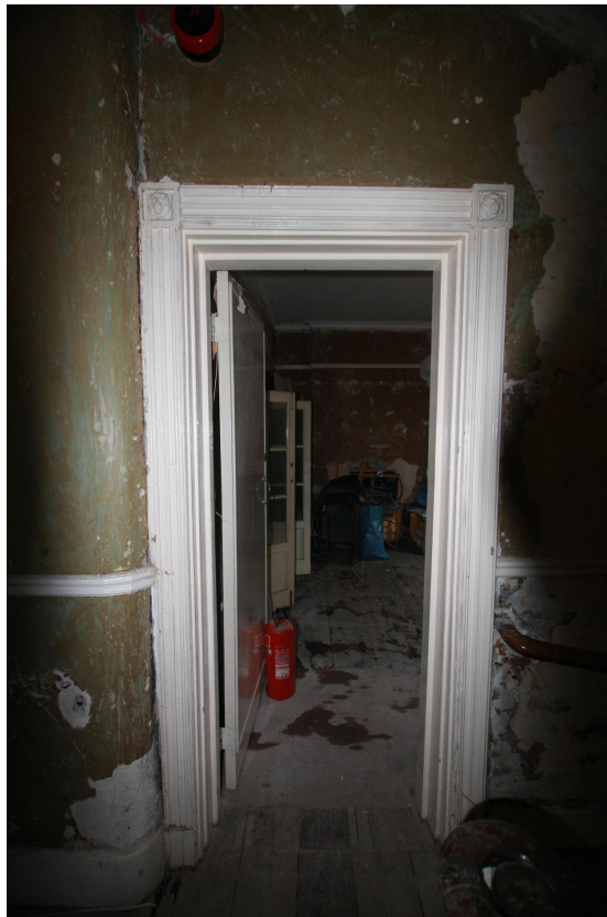
Existing gr. floor door frame & architrave
