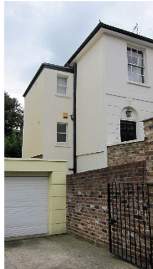
2. Garage next door
