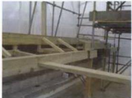
G30 Shuttering 2-9-09.jpg
