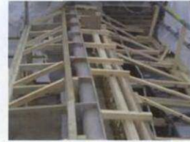
G28 Shuttering 2-9-09.jpg
