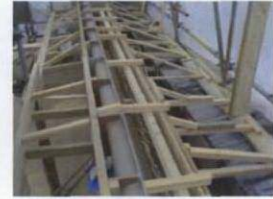
G29 Shuttering 2-9-09.jpg
