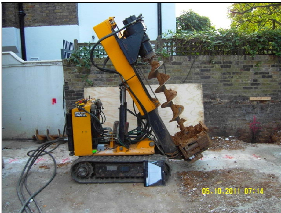
Fig 2. Mini piling rig suited to this site
