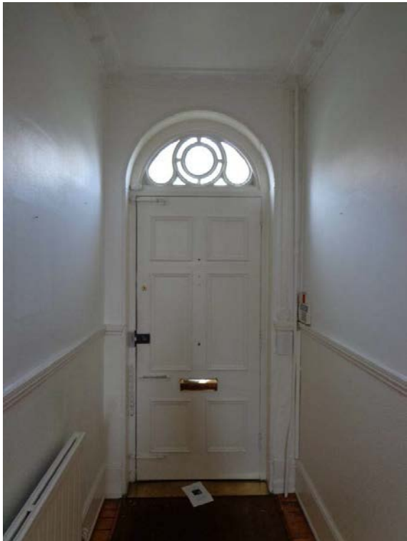
3.44 Fanlight above front door
