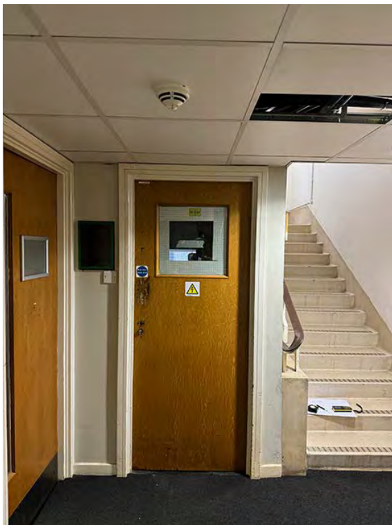
IMG_0910 original 'terrazzo' stair
