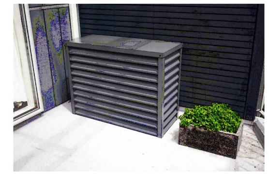
TYPICAL - HOUSING EXAMPLES FOR HEAT PUMP UNITS. CONTRACTOR TO PROPOSE SOLUTION IN TENDER.
