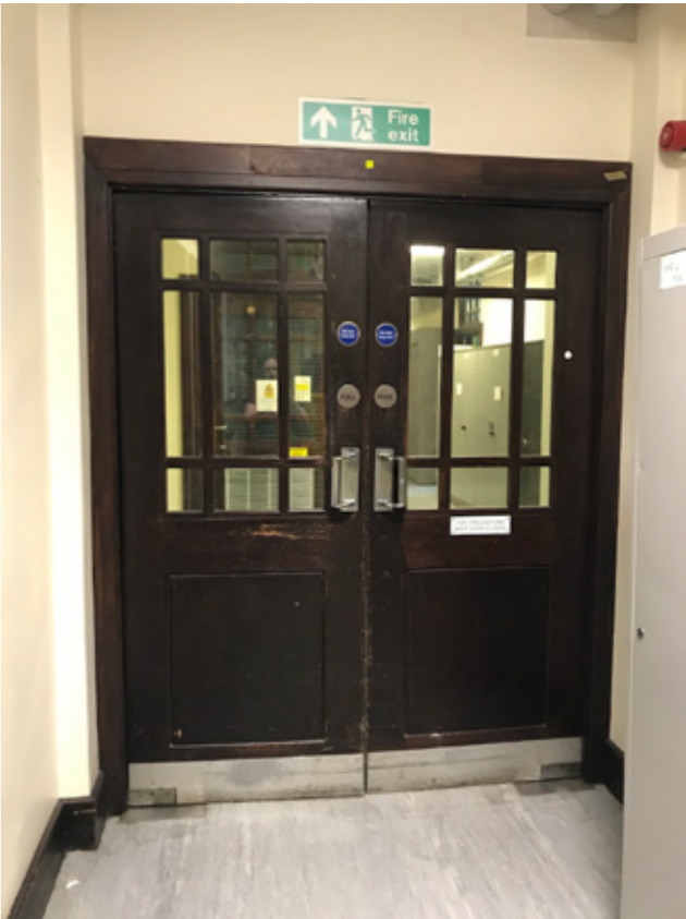
Photograph P2: Existing Door D.3.6
